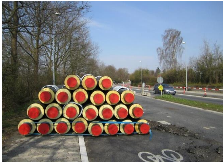
Figur 1 – fjernvarmeledninger til brug for udlægning af et nyt fjernvarmenet og etablering af transmissionsledning.
