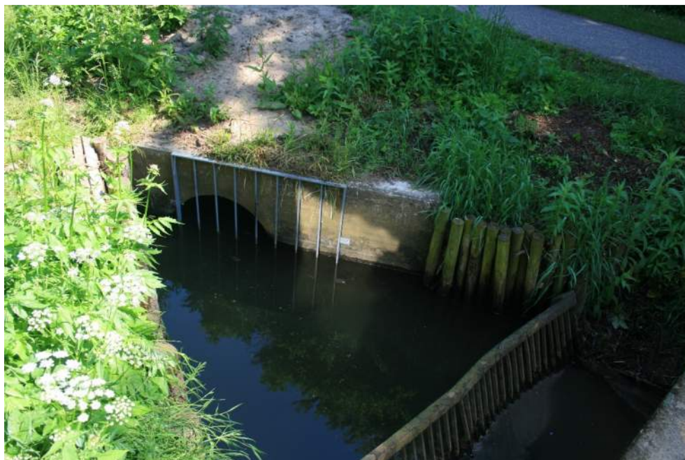
Figur 5-5 Indløbet til Østre Enges Landkanal fjernes
