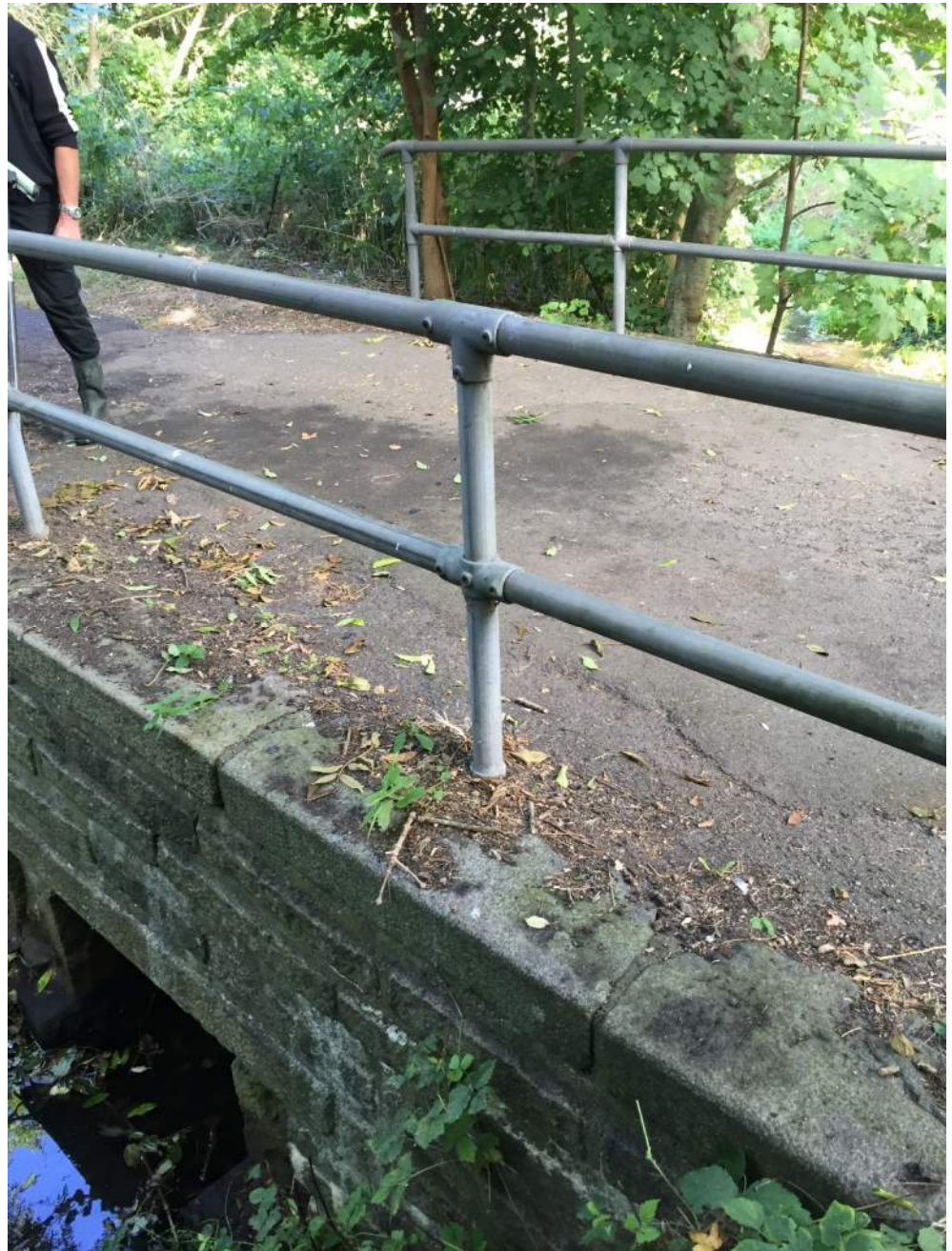
Figur 5-2 Banebroen over vandløb 4d skal fjernes
