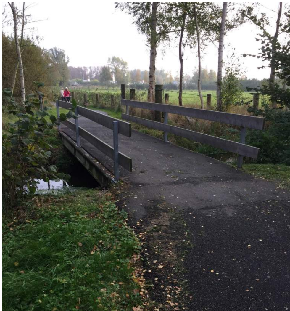
Figur 4-5 Stibro lige opstrøms det planlagte overløb
