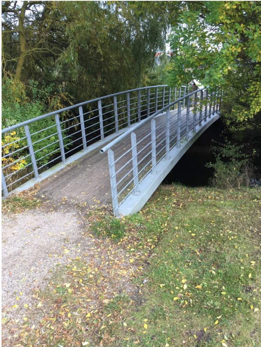
Figur 5-3 Eksempel på stibro med bærende stålkonstruktion, stålrækværk og trædæk (bro ved Barfods Dam, Bogense)
