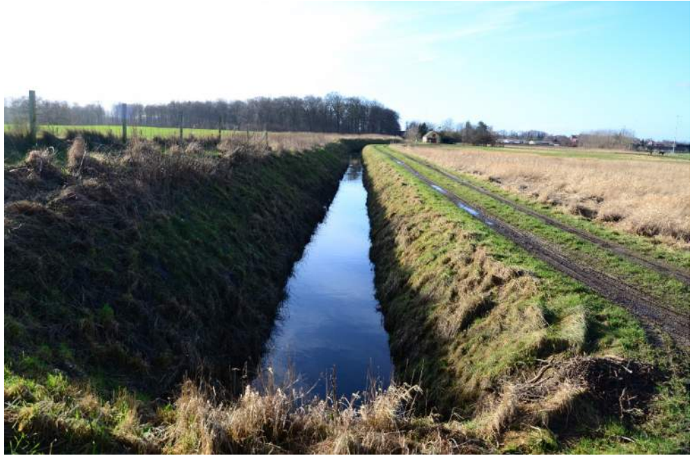
Figur 7-2 Østre Enges Landkanal set fra overkørsel ved Østre Enges pumpestation mod vest. Denne overkørsel fjernes.
